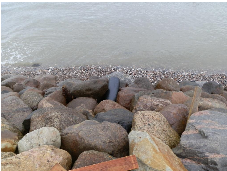
Figur 16 Billede af eksisterende udløb, fra Helsingør Kommunes registrering
