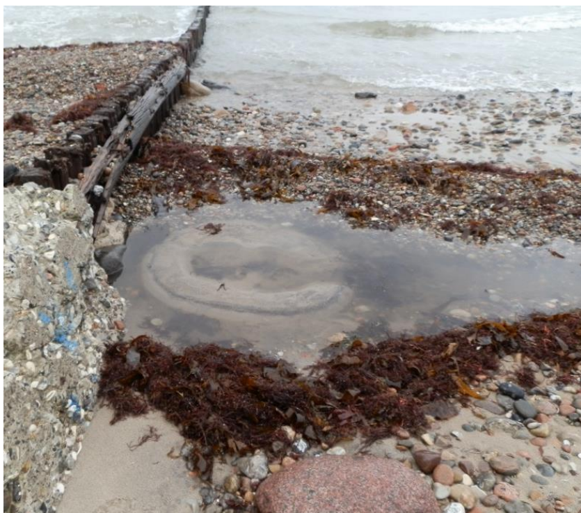
Figur 7 Billedet af nærmeste brønd ud for eksisterende udløb, fra Helsingør Kommunes registrering
