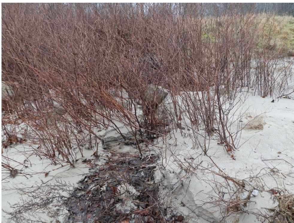
Figur 8 Billede af eksisterende udløb, fra Helsingør Kommunes registrering
