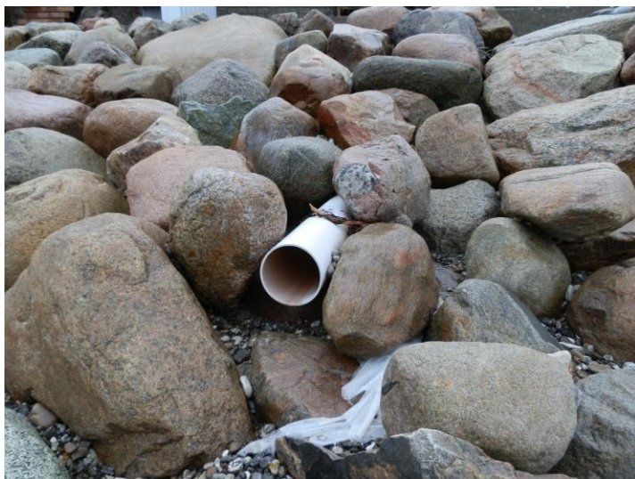
Figur 10 Billede af eksisterende udløb, fra Helsingør Kommunes registrering
