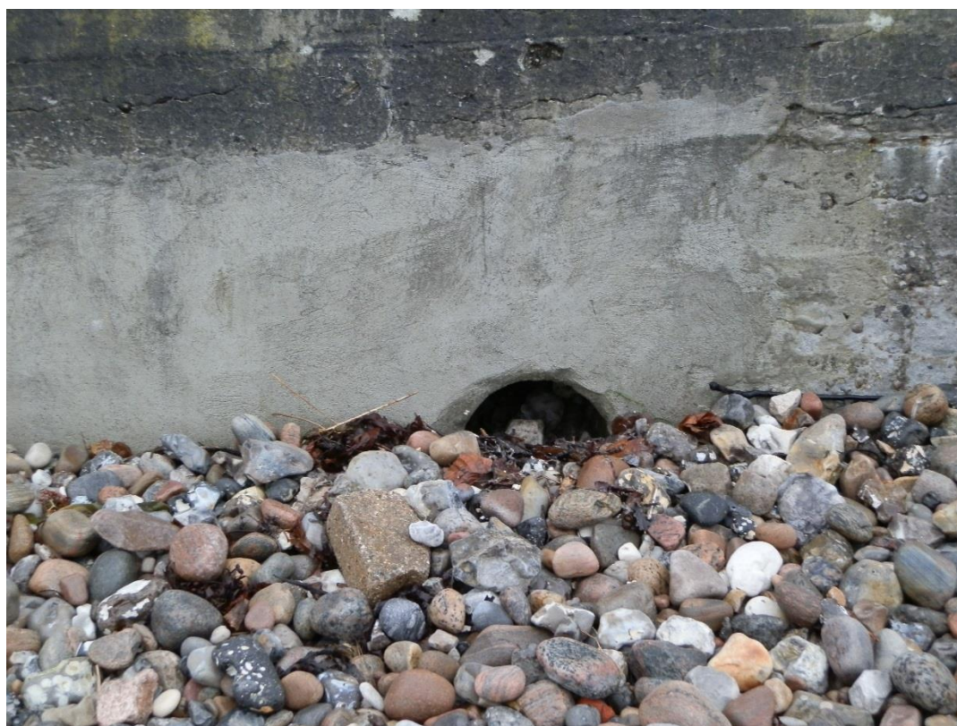
Figur 9 Billede af eksisterende udløb, fra Helsingør Kommunes registrering
