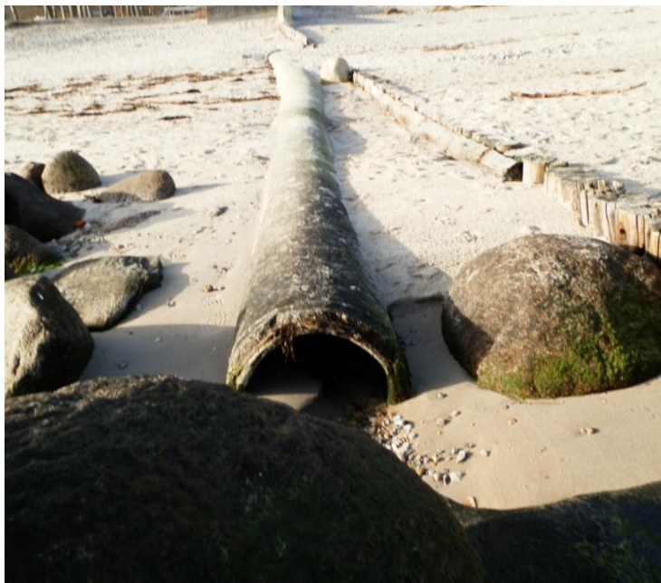
Figur 6 Billede af eksisterende udløb, fra Helsingør kommunes registrering.
