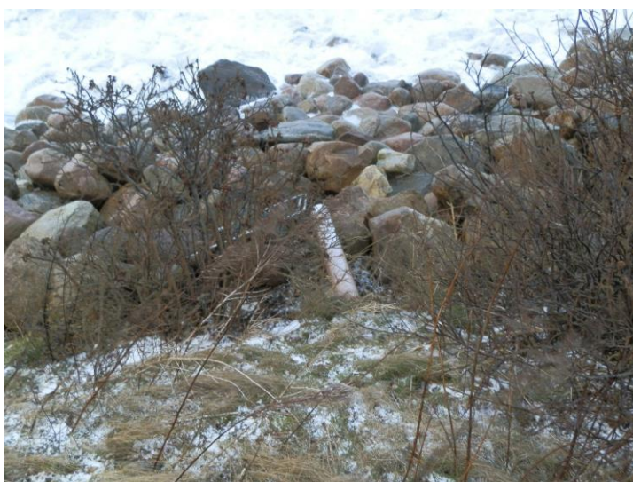
Figur 15 Billede af eksisterende udløb, fra Helsingør Kommunes registrering.
